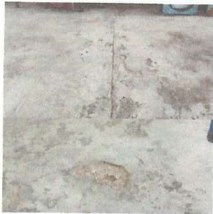
Foto 1: Mejoramiento y sustitución de piso
