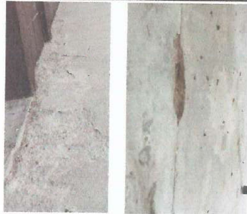
Foto 2: Mejoramiento y sustitucion de piso
