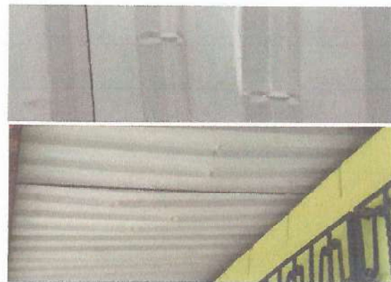
Foto 4: Sustitución de techo
