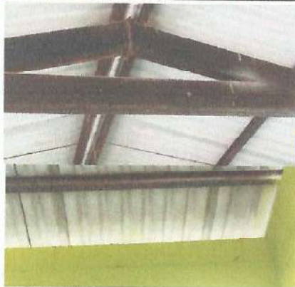
Foto 3: Mejoramiento de estructura de techo
